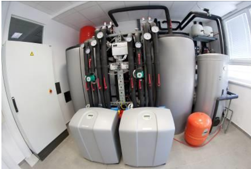
Slika 6.6: Kombinacija rezervoarja tople in hladne vode, grelnika in reverzibilne toplotne črpalke v toplotni postaji
