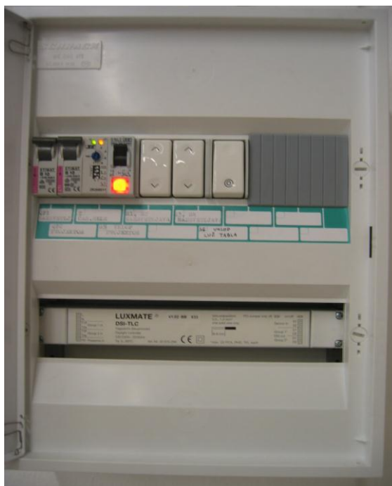
Slika 6.8.: Senzor prisutnosti i osvjetljenja; ormarić za upravljanje osvjetljenjem s 4 kombinacije
