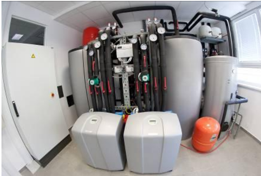
Slika 6.6.: Kombinacija spremnika za toplu i hladnu vodu, kotlova i reverzibilne toplinske pumpe u toplinskom razdjelnom postrojenju
