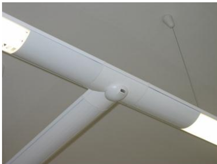
Slika 6.7.: Suvremeno fluorescentno osvjetljenje s DALI kontrolom (digitalno sučelje za automatizaciju)
