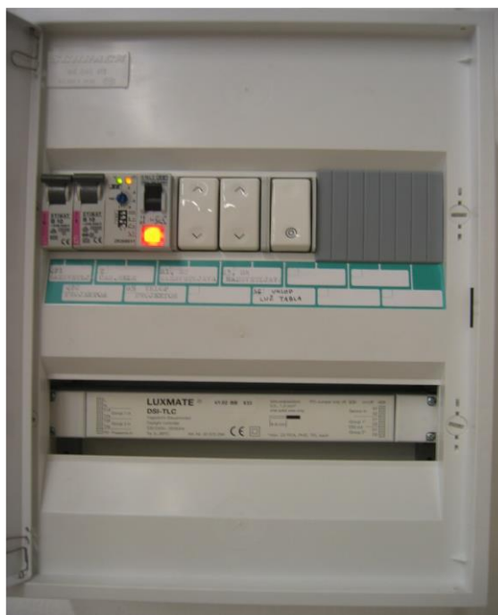
Slika 6.8: Senzor zasedenosti in razsvetljave; nadzorna omarica razsvetljave s 4 stopnjami
