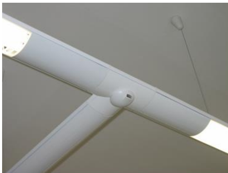
Slika 6.7: Sodobna fluorescentna razsvetljava z nadzorno funkcijo DALI
