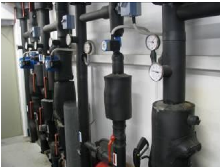
Slika 6.5.: Suvremeni distributer tople vode
