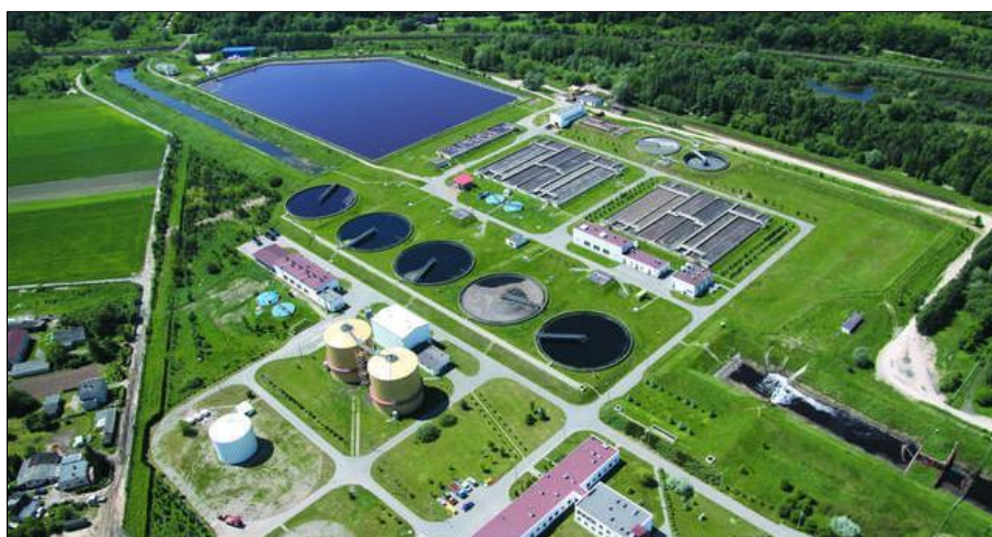
Fig. 19. „Kapuściska” sewage treatment plants in Bydgoszczy ( www.chemwik.pl )
