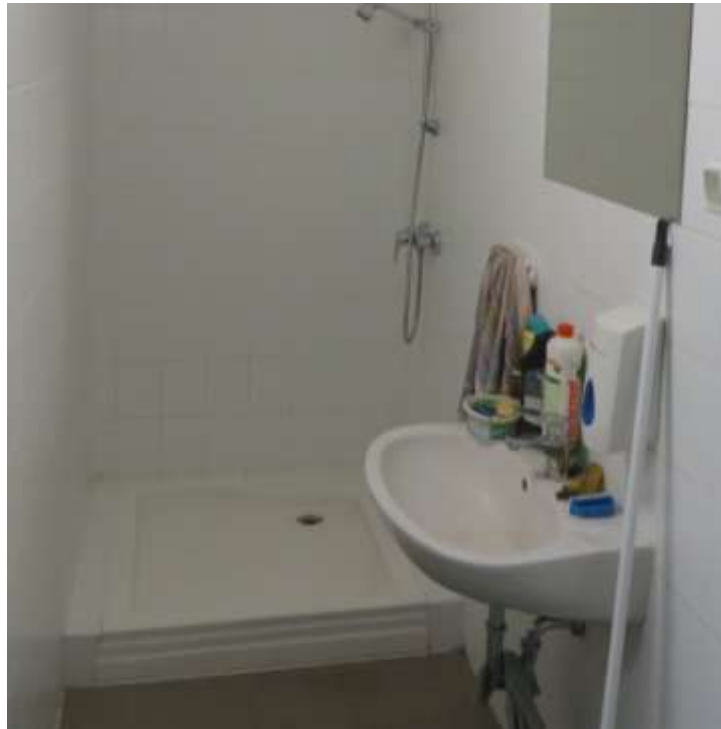
27. ábra Zuhanyzó az St épület alagsorában
