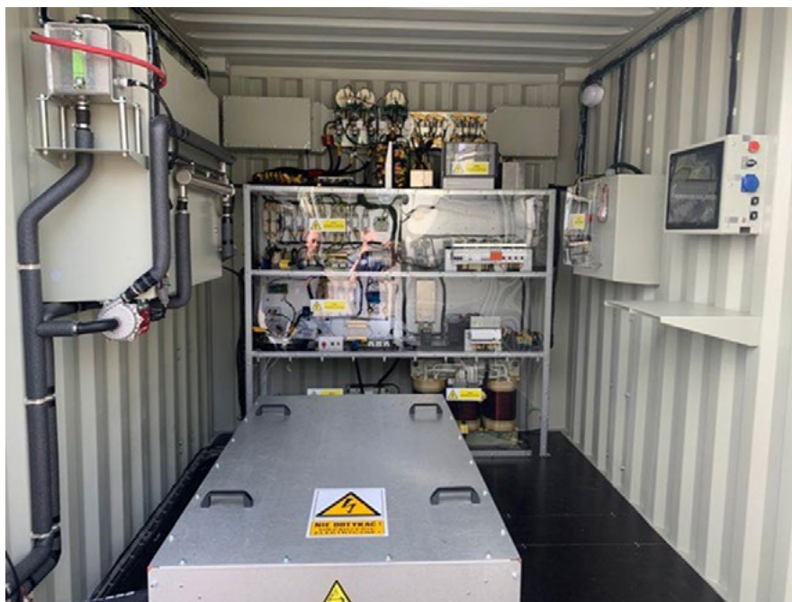
Figura 4: accumulo di energia elettrica a batteria; utilizzo di una batteria di trazione di seconda vita di un filobus (Fonte: PKT di Gdynia)
