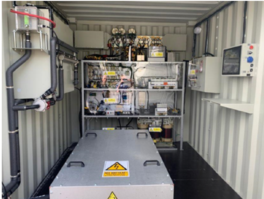
Abbildung 4: Batteriebasierte elektrische Energiespeicherung; Verwendung einer wiederverwendeten Antriebsbatterie aus einem Trolleybus (Quelle: PKT Gdynia)
