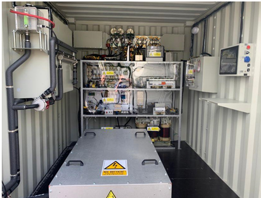
4. ábra: Akkumulátor-alapú elektromosenergia-tárolás; egy trolibuszból származó, második életciklusú hajtóakkumulátor felhasználása (Forrás: PKT Gdynia)
