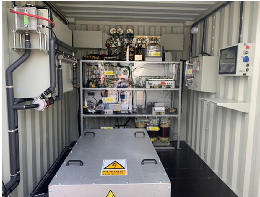
Slika 4: Pohrana električne energije u akumulatoru; korištenje vučnog akumulatora iz trolejbusa s novom svrhom (Izvor: PKT Gdynia)
