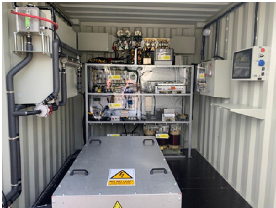
Slika 4: Shranjevanje električne energije v baterijah; uporaba rabljene pogonske baterije iz trolejbusa (Vir: PKT Gdynia)
