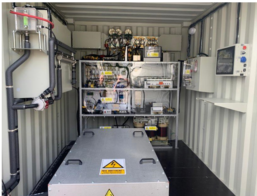
Obrázok 4: Skladovanie elektrickej energie na báze batérií; použitie trakčnej second-life batérie z trolejbusu [Zdroj: PKT Gdynia]
