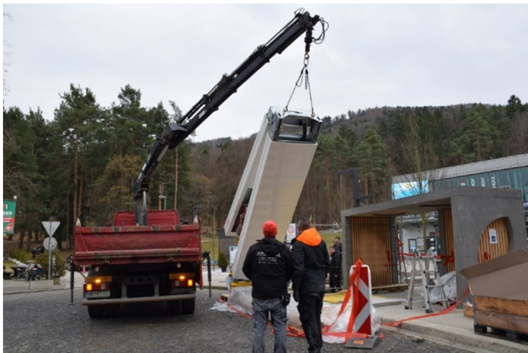
Slika 20: Namestitev odjemnika toka s hitrim polnjenjem na postaji vzpenjače v Mariboru
