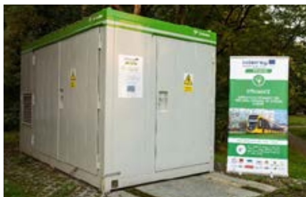
Rysunek 5: Akumulator stacji przechowywania buforowego w Pilźnie (PMDP)
