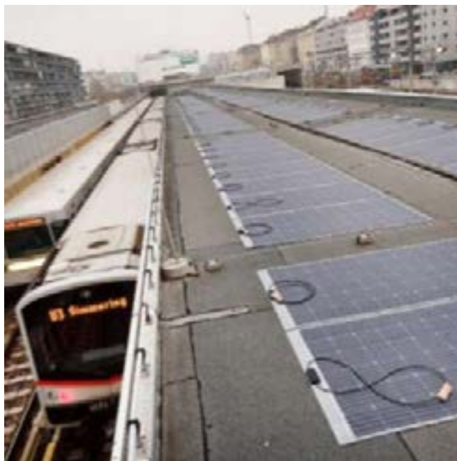
Rysunek 8: Folie fotowoltaiczne na dachu stacji metra (Wiener Linien)
