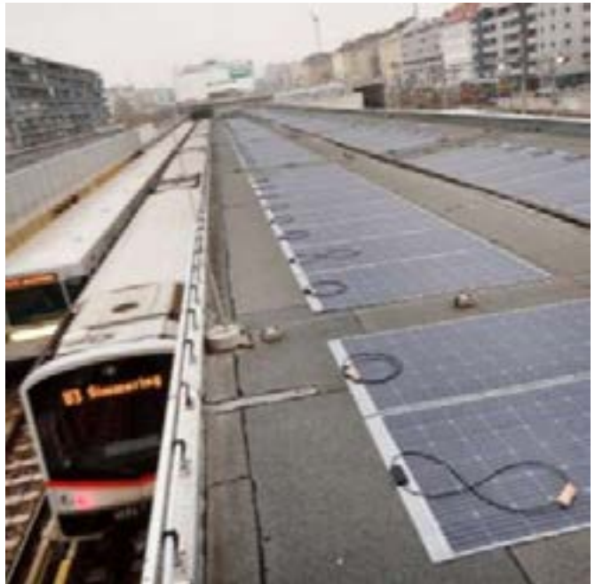
Abbildung 8: PV-Folien auf dem Dach der U-Bahn-Station (Wiener Linien)
