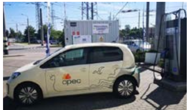
Abbildung 6: Mobile Ladestation für Elektroautos, die über das Trolleybus-Netz betrieben werden (PKT)
