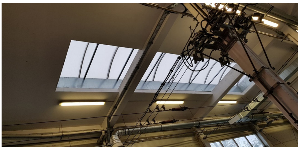
Slika 11: Zamijenjeni krovni svjetlarnici na depou PKT Gdynia (fotografija Marcin Wolek)
