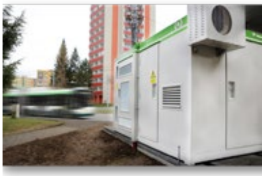
Slika 10: PMDP je preizkusil postajo vmesnega hranilnika s trolejbusom IMC z namenom nadomestiti dizelske avtobuse. Vir: PMDP.
