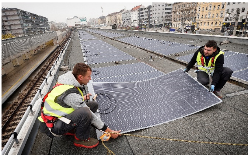
Obrázok 6: Inštalácia fotovoltickej fólie vo Viedni. Zdroj: WL.
