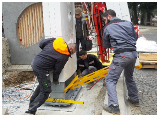
Obrázok 15: Inštalácia rýchlonabíjačky v Maribore. Zdroj: Mesto Maribor.
