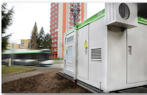
Obrázek 10: Společnost PMDP testovala vyrovnávací úložiště s trolejbusem NVP jako náhradu za autobusy se spalovacími motory. Zdroj: PMDP.
