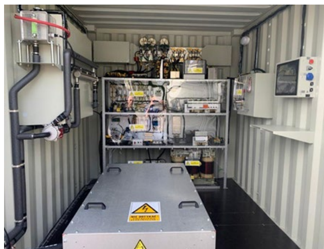
Abbildung 5: Batteriebasierte elektrische Energiespeicherung; Verwendung einer wiederverwendeten Antriebsbatterie aus einem Trolleybus. Quelle: PKT.
