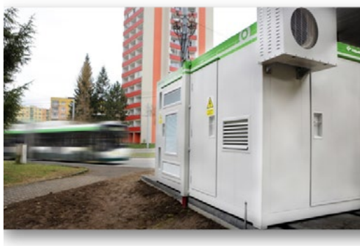
Abbildung 10: PMDP testete eine Pufferspeicherstation mit einem IMC-Trolleybus als Ersatz für Dieselbusse. Quelle: PMDP.
