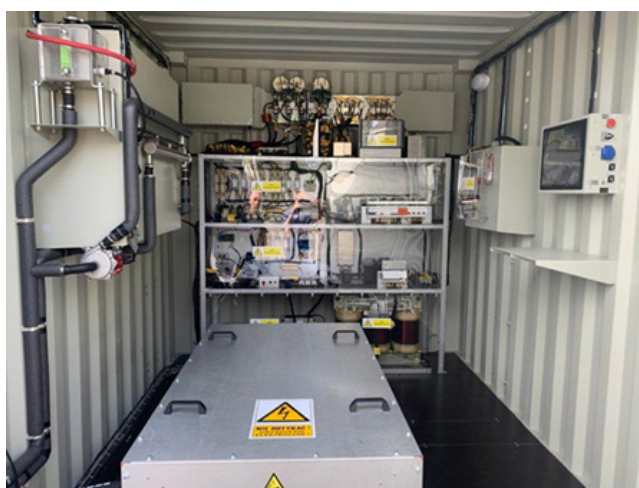
Obrázok 5: Skladovanie elektrickej energie na báze batérií; využitie použitej trakčnej batérie z trolejbusu. Zdroj: PKT.
