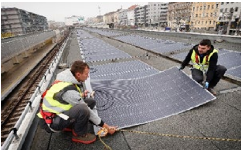
Slika 6: Montaža PV folije na Dunaju. Vir: WL
