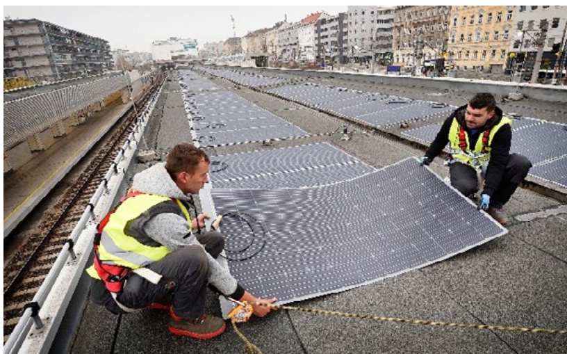
Obrázek 6: Instalace fotovoltaické fólie ve Vídni. Zdroj: WL.
