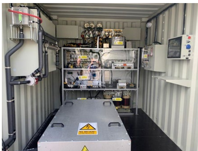
Obrázek 5: Skladování elektrické energie na bázi baterií; použití trakční baterie s druhou životností z trolejbusu. Zdroj: PKT.
