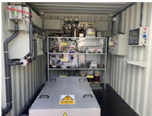
Slika 5: Shranjevanje električne energije v baterijah; uporaba rabljene pogonske baterije iz trolejbusa. Vir: PKT.
