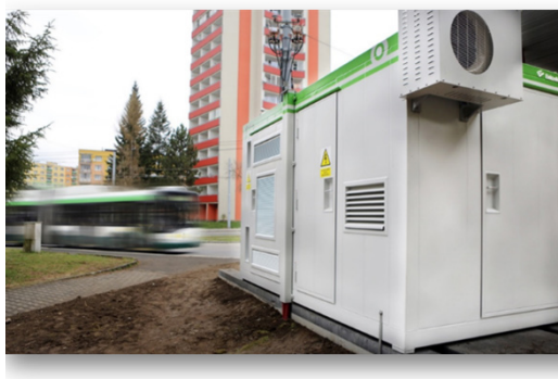
Obrázok 10: Spoločnosť PMDP testovala vyrovnávaciu stanicu pre trolejbus IMC, ktorý má nahradiť naftové autobusy. Zdroj: PMDP.
