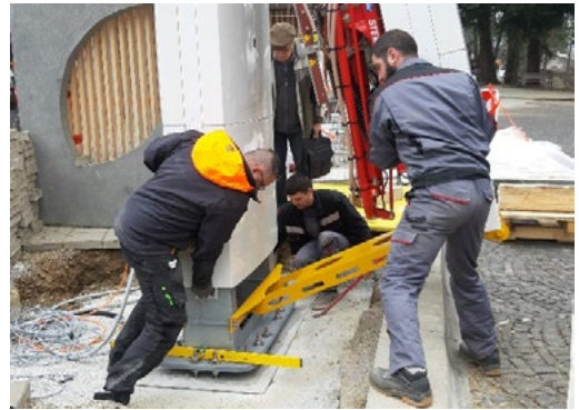
Abbildung 15: Installation eines Schnellladegeräts in Maribor. Quelle: Stadt Maribor.
