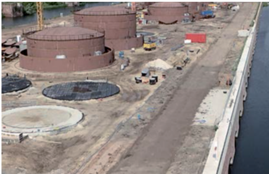
Rys. 4.5. Przebudowa terminala Kędzierzyn-Koźle
