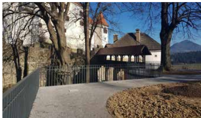
Zdjęcia 39-42: zdjęcia u góry - stan przed renowacją, zdjęcia u dołu - stan po renowacji
